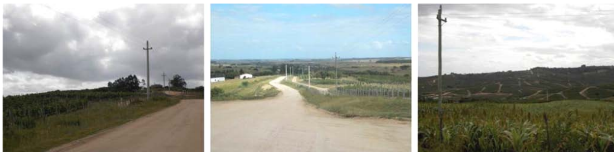
Figura 27 . Tendido eléctrico dentro del ámbito de actuación.
