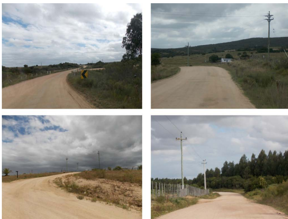
Figura 24 . Arriba: izq.: Camino Sainz Martínez intersección con camino de acceso este a polígono; der.: camino de acceso este a polígono. Abajo: izq.: Camino Sainz Martínez intersección con camino acceso oeste a polígono, der.: camino de acceso oeste a polígono.
